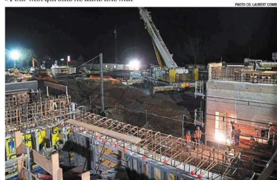
Cette vue montre que les culées sont creuses. Elles vont soutenir le tablier que le camion-grue va bientôt déplacer, mais aussi accueillir un ascenseur pour chaque quai ainsi qu'un local technique SNCF.
